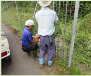
協力して侵入箇所を補修
